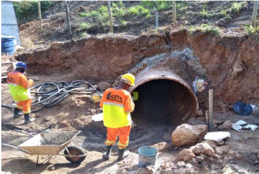
Foto 11 – Ampliação Bueiro – Km 29+000 Norte
