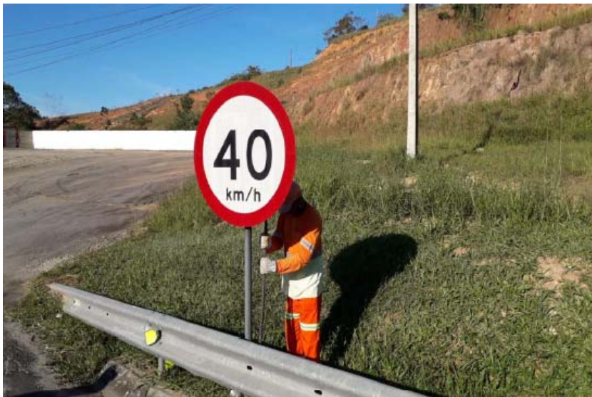
Foto 2 – Nivelamento de placa – Km 3+200 Norte
