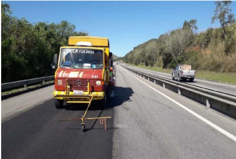
Foto 1 – Pintura de faixas – Km 5+800 Sul
