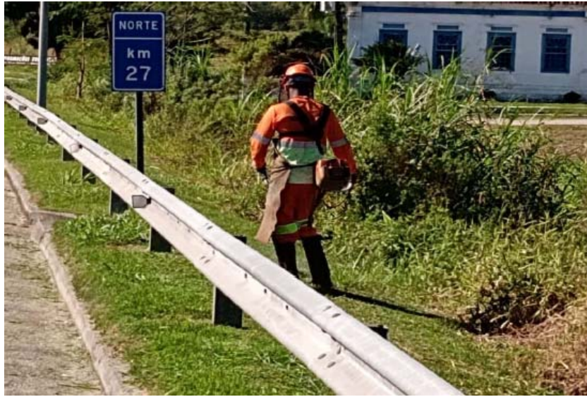
Foto 7 – Roçada Manual – Km 27+000 Norte
