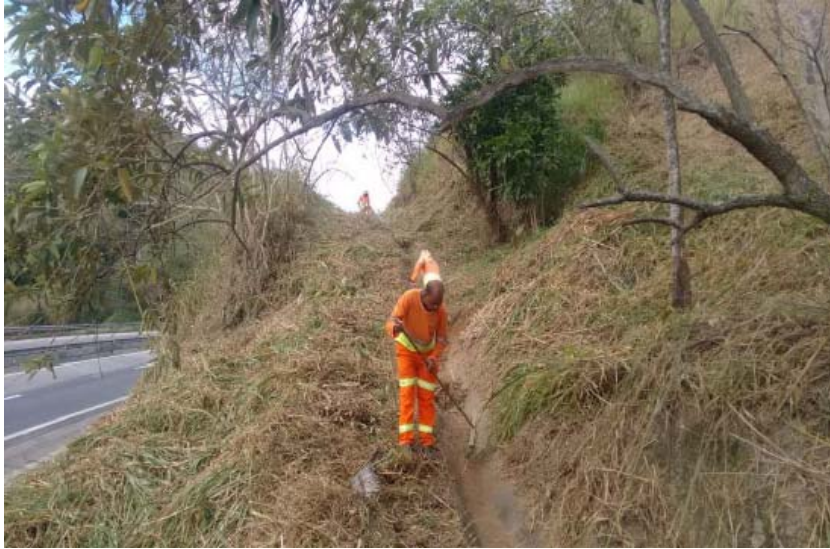
Foto 5 – Limpeza de valeta de corte– Km 2+600 Norte
