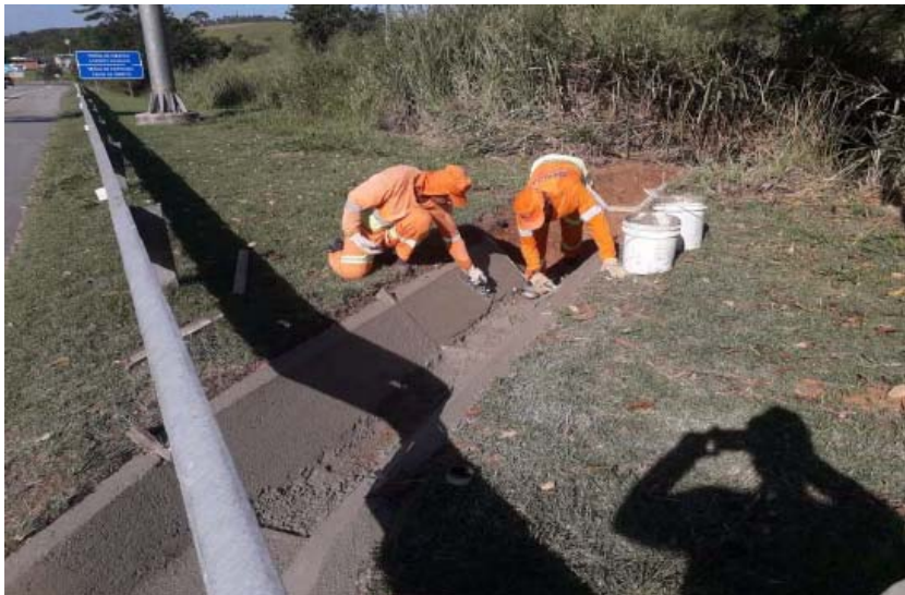
Foto 6 – Recuperação de descida d'água – Km 21+500 Norte
